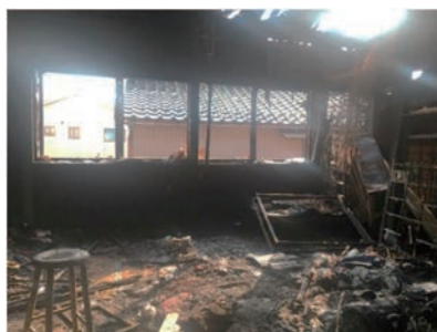
石川県金沢市 現場の様子
